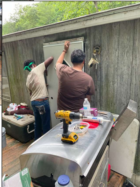
BACK DOOR REPLACE
